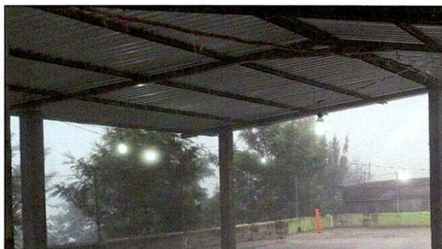
Foto 4: Cubierta de lámina
