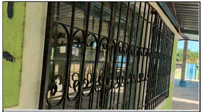
Foto 7: Sustrucción de balcones
