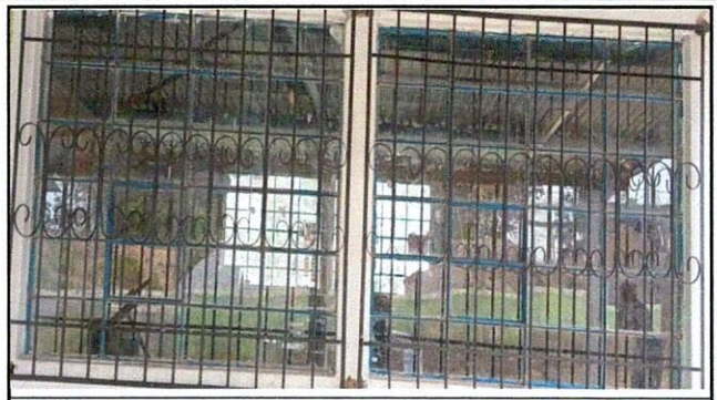
Foto 8: Sustrucción de balcones
