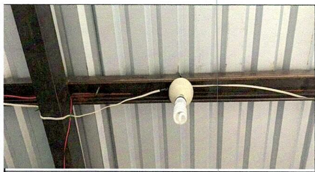
Foto 5: Reparación de sistema eléctrico
