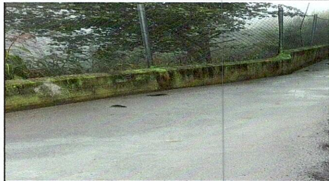
Foto 1: Sustrucción de piso
