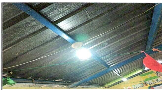
Foto 6: Reparación de sistema eléctrico
